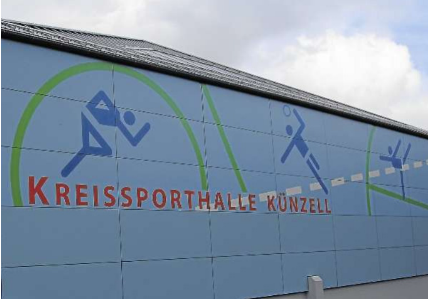
Die Turnhalle der Don-Bosco-Schule in Künzell wurde für eine Million Euro im Außenbereich erneuert. Die Optik hat sich völlig verändert. Die asbesthaltigen Faserzement-Wellplatten an Dach und Fassade wurden entfernt. Die Handwerker haben die Dämmung an Dach und Fassade ergänzt, das Dach mit Zinkblech neu eingedeckt und Fassade mit glatten, großformatigen Platten verkleidet. Aus den bislang drei Giebeln, die vom Parkplatz des Gemeindezentrums gut zu sehen waren, wurde eine einheitliche Fassade mit nur noch einem Giebel.
