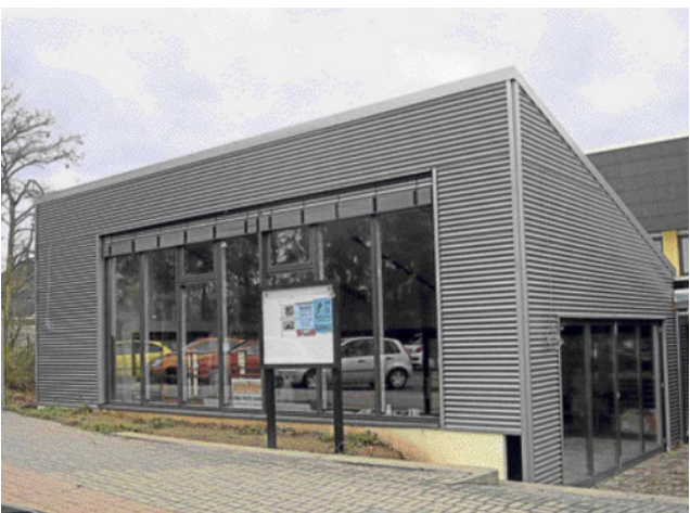
Die Kreissporthalle an der Hünfelder Jahnschule wurde für 1,5 Millionen Euro saniert und erweitert.
