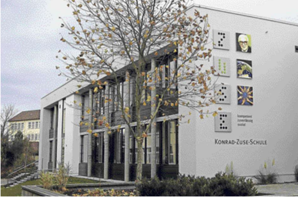
Die Konrad-Zuse-Berufsschule in Hünfeld hat für 900 000 Euro einen komplett neuen Erweiterungsbau für sechs Klassen- und einen Gruppenraum erhalten.
