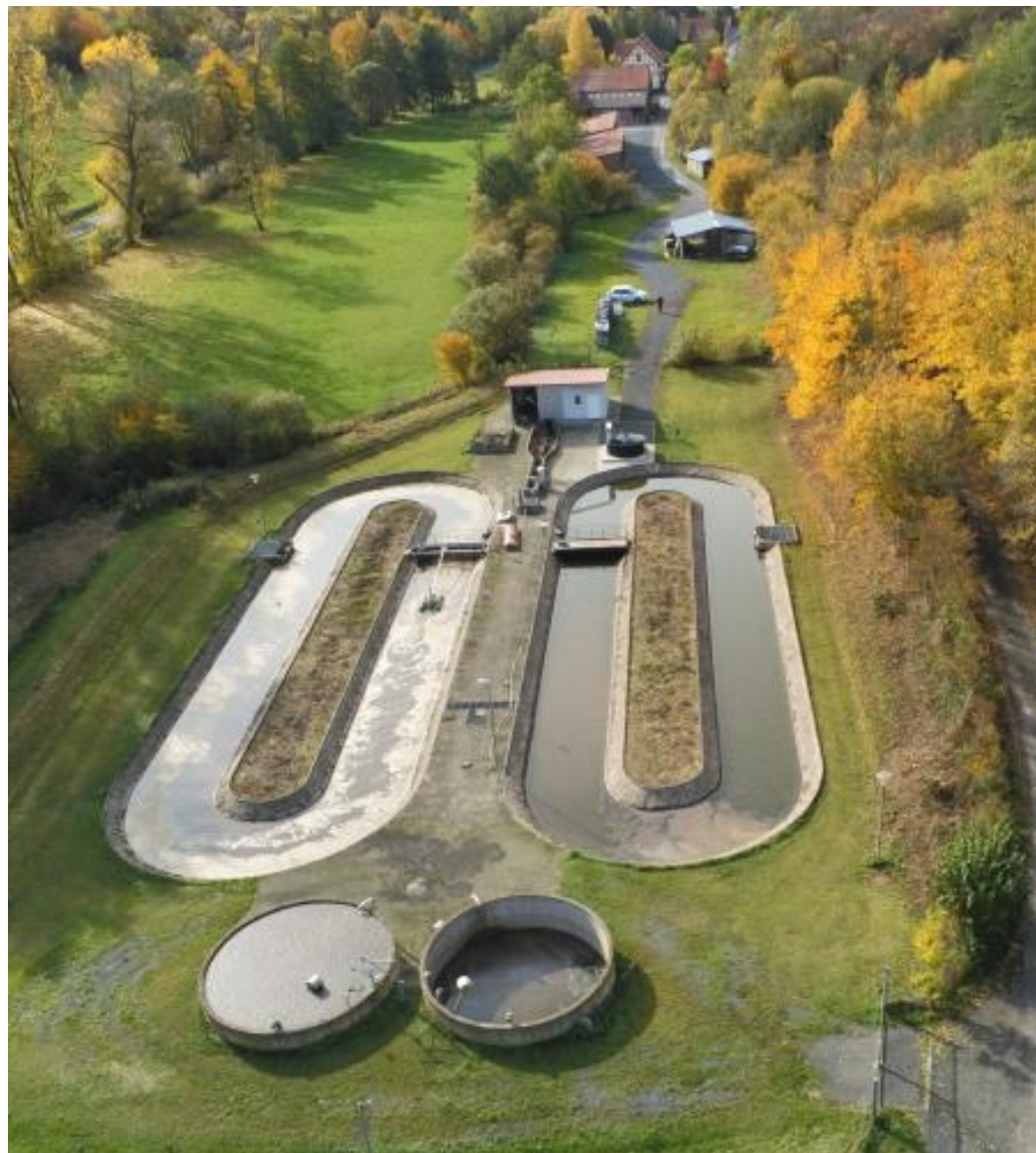
Eine kleinere Anlage im Landkreis ist die Kläranlage in Großtaft, an die rund 1000 Einwohner angeschlossen sind. Jährlich fallen 240.000 Kubikmeter Abwasser an. Foto: bionic-IT
